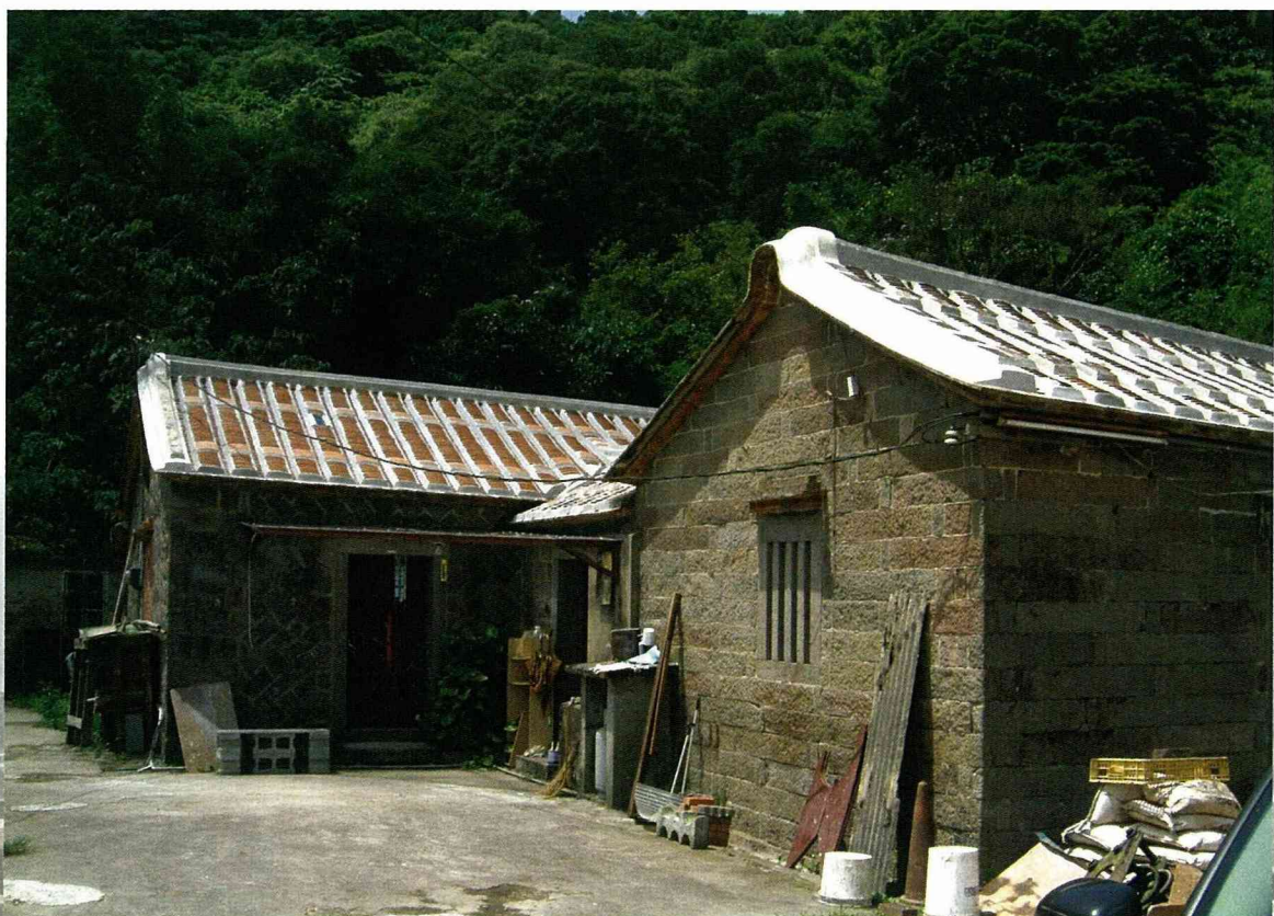
以石為外牆建材的傳統建築
