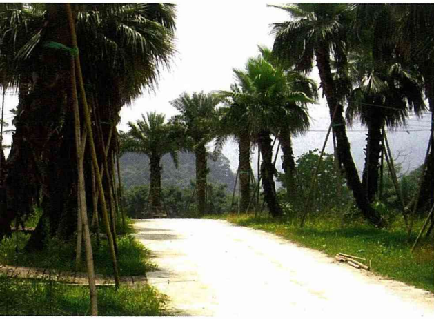
考慮實際使用需求的水泥鋪面車道
