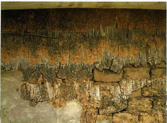
以土及稻稈等自然材質所構築的土埆厝外牆
