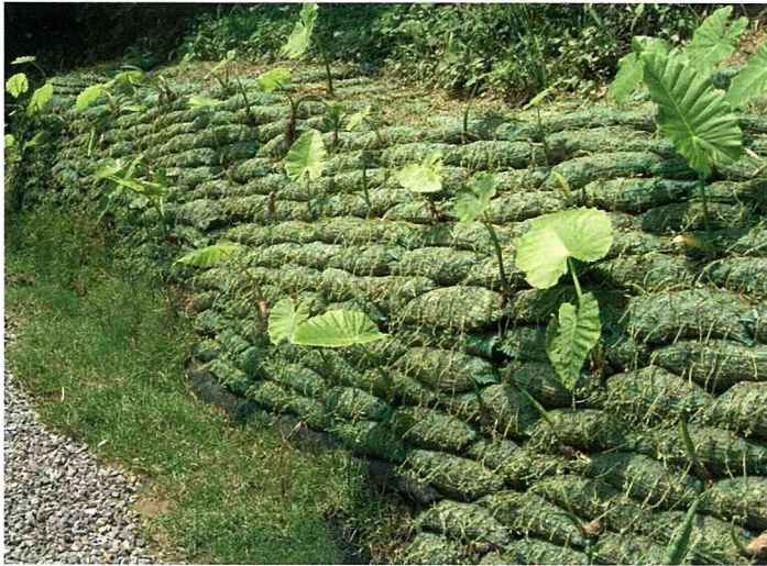
由植生土包所堆砌而成的景觀坡坎
