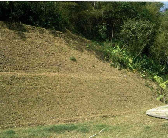
以生態工法構築成擋土坡坎
