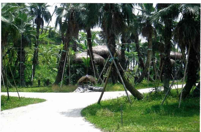
考量車道強度所使用的混凝土鋪面
