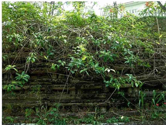
數年後坡坎上的植物生長已穩定，足以穩固土石，杉木圍籬功成身退
