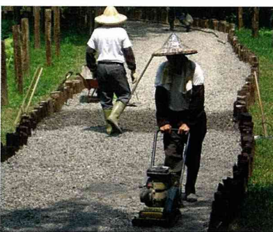
碎石步道鋪面夯實作業
