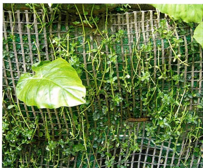
土包表面防止雨水沖刷所種植的過長沙
