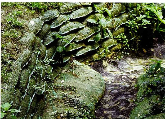
土石包底部的排水渠道
