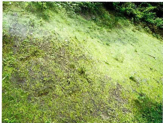
以生態工法施做完成的坡坎，草木得以穩定生長，進而緊護大地
