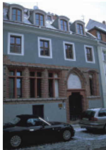
圖2：在格立姿鎮的一棟民房上（德國薩克森邦），較老的建築牆體仍明顯可見
