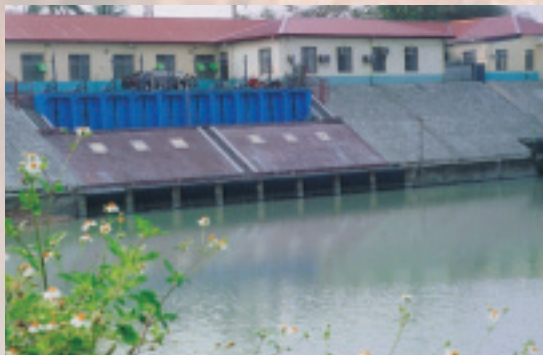
曹公圳 取水口
