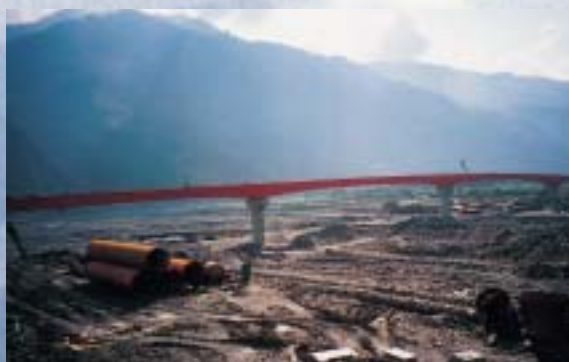
重建中的橋樑工程
