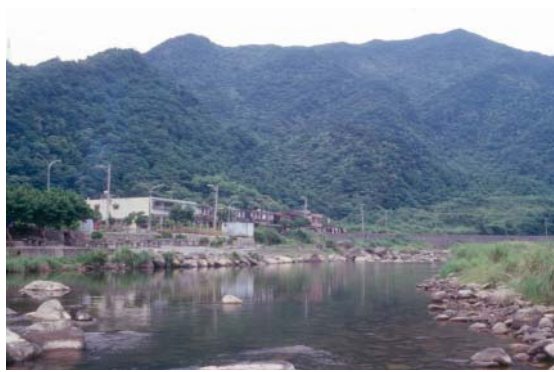
1998員山子分洪道未施工前之基隆河外觀
