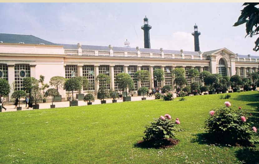
如尖塔般直立的煙囪為暖爐系統
