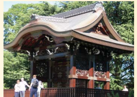
同樣具有東方建築風格的日式亭子
