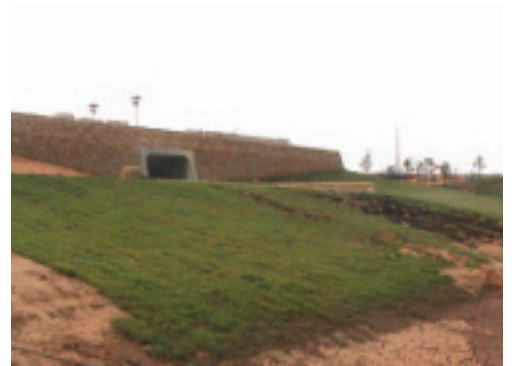
箱涵排入滯洪池
