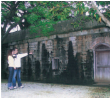
地踞「五虎崗」上的滬尾砲台
