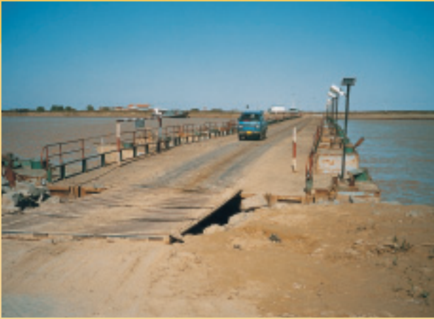
黃河口搭建的浮動鋼板橋
