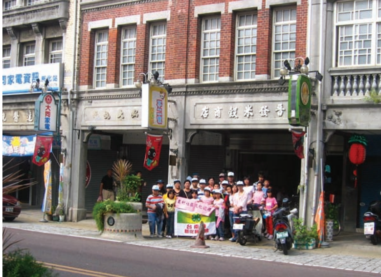
新化老街的巴洛克式建築
