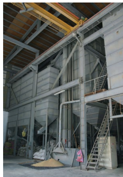
協成製材碾米工廠更新碾米廠房與各項設備
