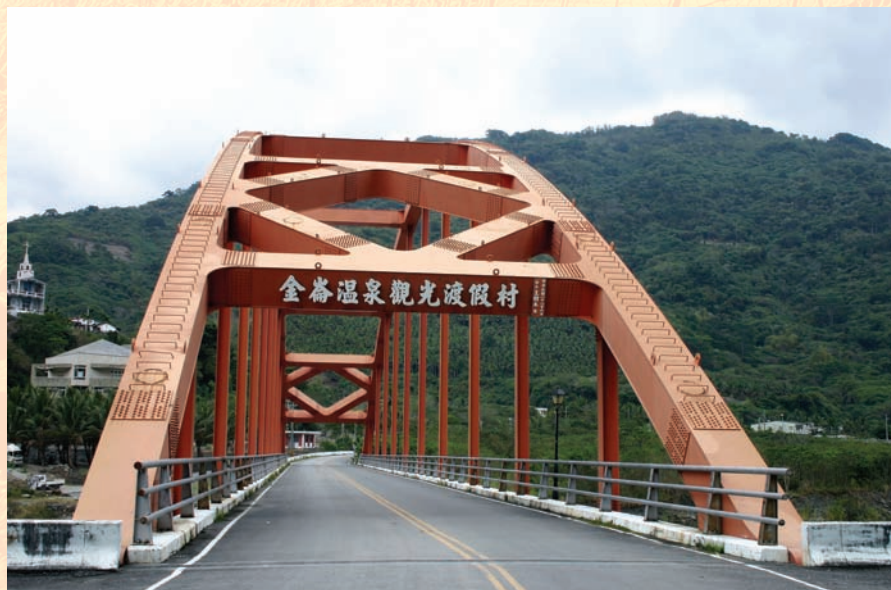
金崙溫泉景觀橋
