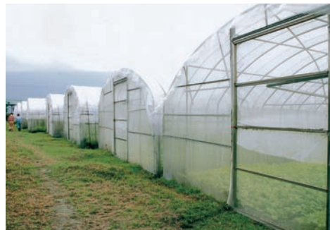
隧道棚網室設施
