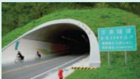
玉長隧道東端入口
