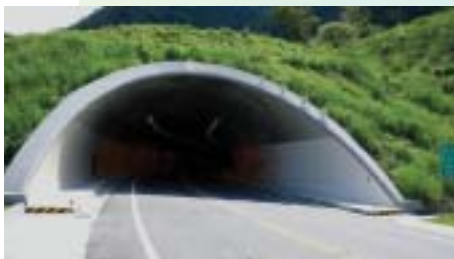
玉長隧道西端入口
