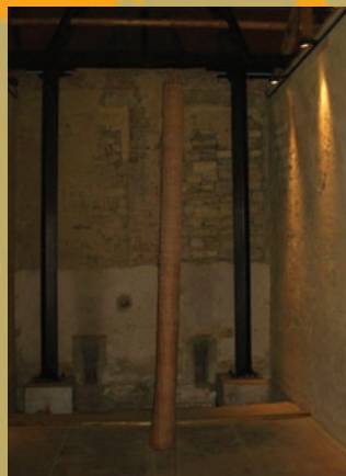
「竹筴圓筒」能引導穀倉內的溼氣到頂端排出
