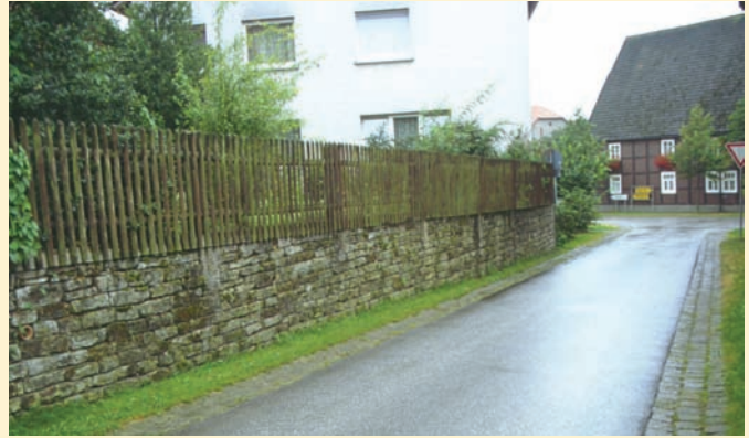
完工後的道路環境
