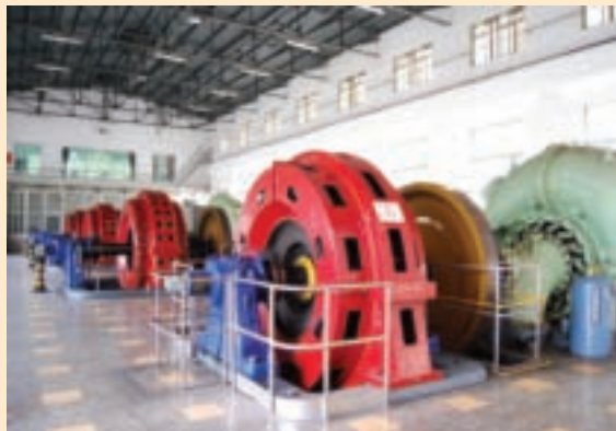
建造於日據時期的蘭陽發電廠天埤分廠
