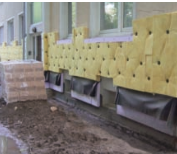
穿衣的建築，有透氣的複層牆，防熱外，也讓建築有了擋風雨層，降低牆體受損的機會。
