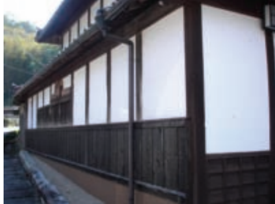
像這樣，房子蓋好後用火燒到炭化，是日本古建築物的特色和技術！
