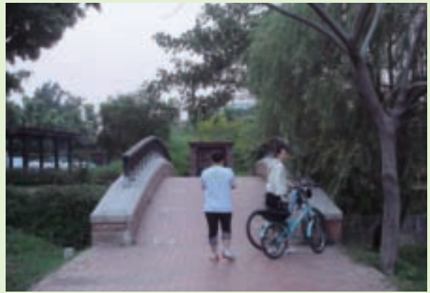
舊鐵橋連結濕地公園，到處都是美景
