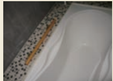
浴缸旁裝上扶手
