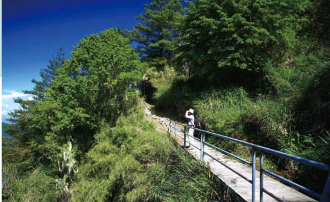
辦理18處森林遊樂區公共設施及景觀改善工程，修建國有林地內步道125公里
