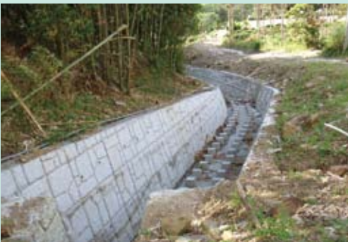
樂野8號下方野溪災害復建工程
