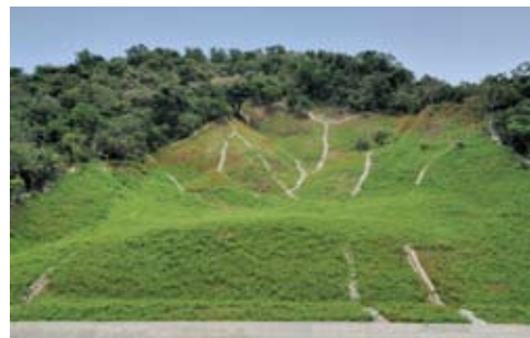
宜蘭縣大同鄉寒溪大橋上游災害復建工程
