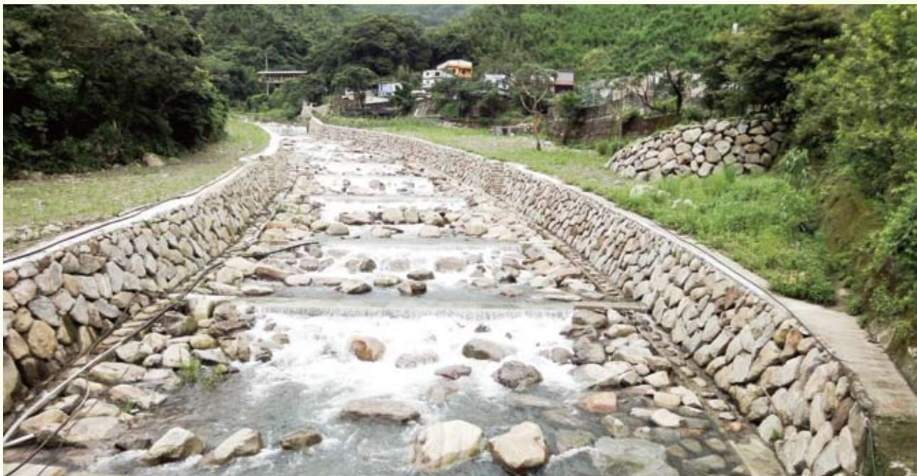
油羅溪煤源六號橋下游野溪二期整治工程
