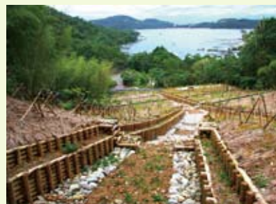
國有林崩場地處理－日月潭巒大區29林班坡面處理工程
