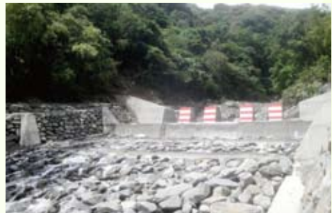
大甲溪環山護岸整治工程
