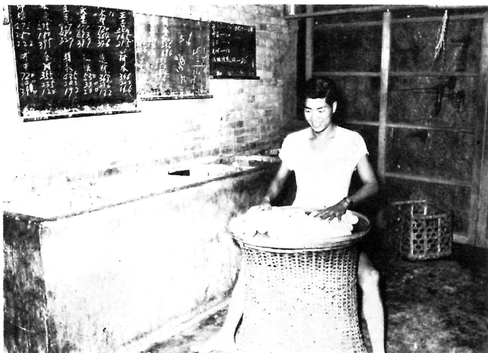
圖(7)：焙籠及其操作牆邊可見孵化缸（此係生卵桶）
