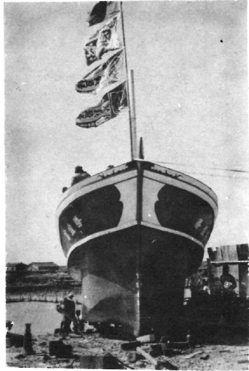
圖(3-8) 鋼骨水泥漁船建造完工
