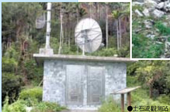
●土石流觀測站
