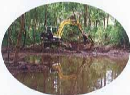
採用古旱水田施作方式，現稱「晶化防滲工法」以達到防水功能。（2005.9）
