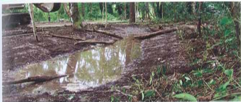
鋪設不透水布來達到防水功能，其上覆土蓄水營造自然溼地狀態。(2005.9)
