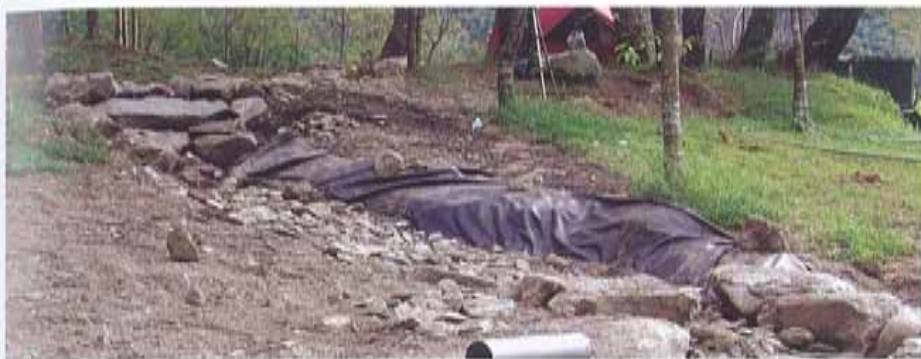
流動水域採用不透水布加強防水處理 (2005.9)
