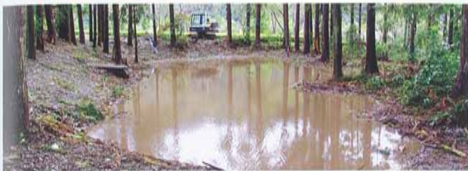
採用「晶化防滲工法」來達到防水功能，使水域內終年有水。(2005.9)
