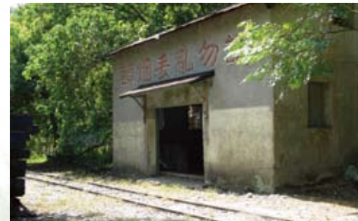
▲存放林場所用的汽、柴油及機油的油庫，防火標語依然鮮明
