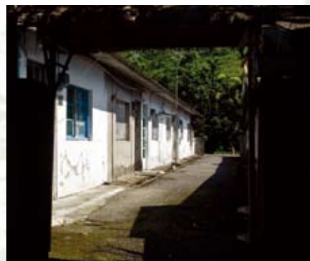
▲水泥宿舍空間狹小夏季悶熱，並未獲得配住基層工人的喜愛
