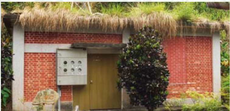
▲林場附設的圖書館（現為機房及通訊基地台）
