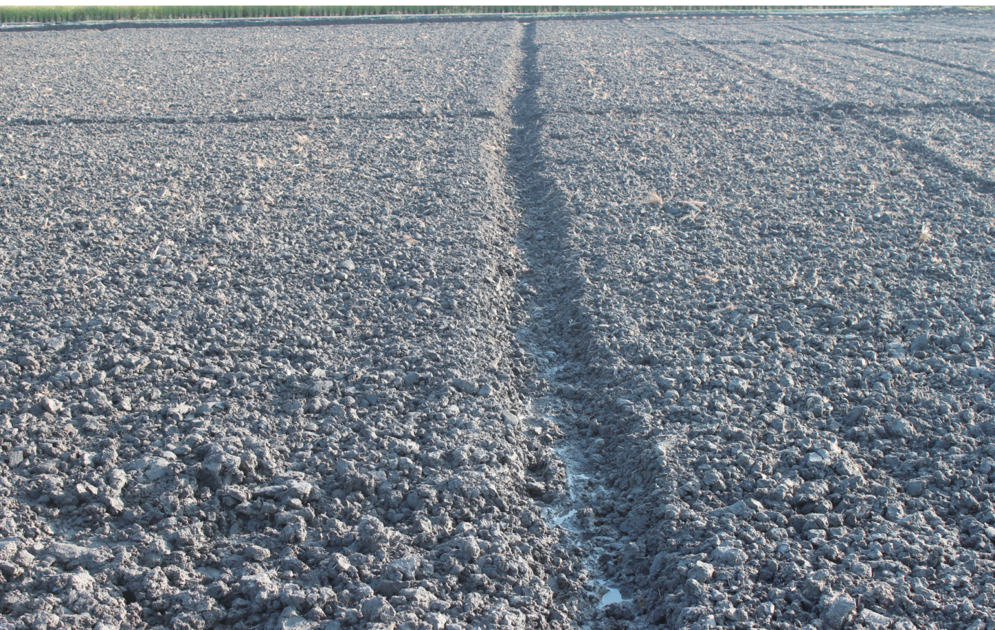
⊗ 於田區開溝，可加速多餘地面水排除 (圖 / 林訓仕)
