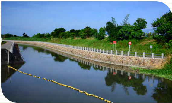
◎宜蘭縣玉田排水（第 1 期）改善工程
