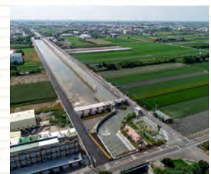
◎雲林濁幹線調蓄池竣工通水增加調蓄水源
