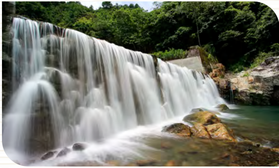
◎裡冷溪防砂壩改善工程
