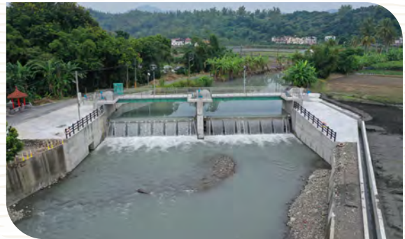
◎高雄市美濃區柚子林線制水閘門改善工程
