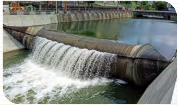
◎屏東縣屏東市永安圳制水閘門改善工程
