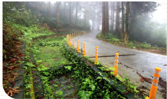
◎ 雙龍林道 0~5.2k 沿線道路第三期改善工程
