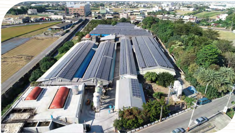
◎養豬場設置屋頂型太陽光電及沼氣發電，除增加收益外，並改善畜牧場環境，同時邁向循環經濟與永續經營
