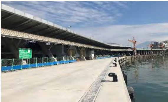
◎東港漁港卸魚碼頭整建後新樣貌
