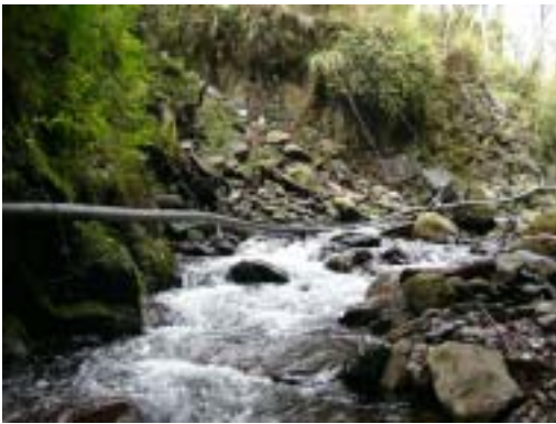
照片 2-48 二號壩斷面
