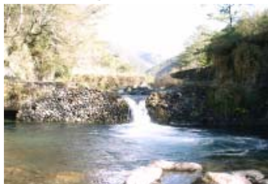
照片 3-1 七家灣溪二號壩
