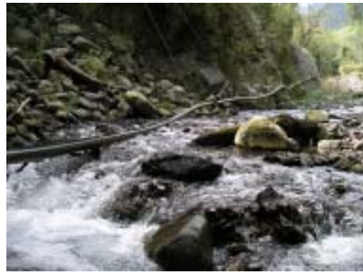
照片 2-49 二號壩斷面
