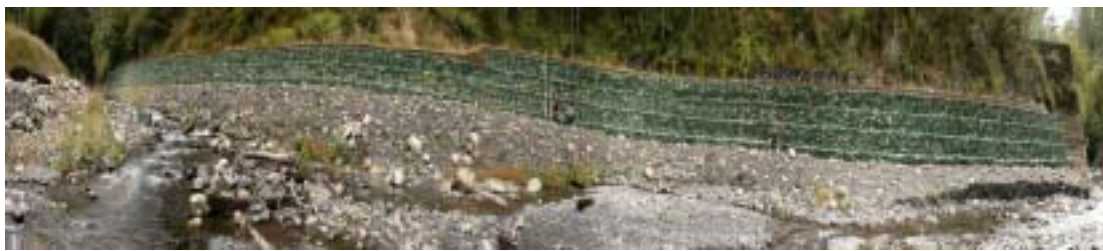
照片 D 一號壩廣角照片
