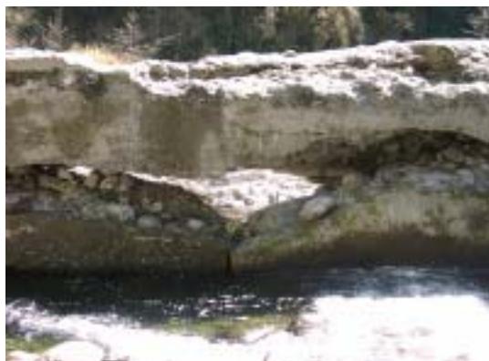
照片 3-10 二號壩副壩特寫
