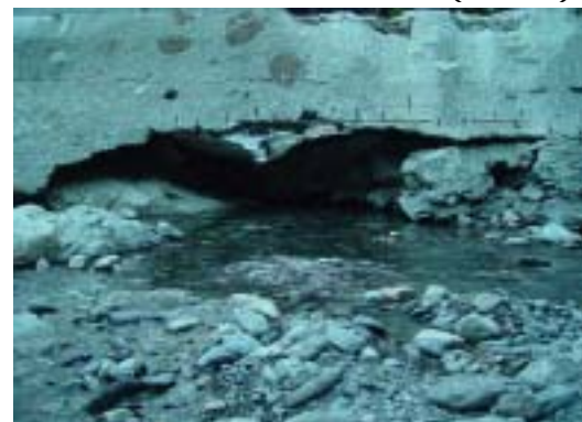
照片 3-15 二號壩副壩正面特寫(92/07)
