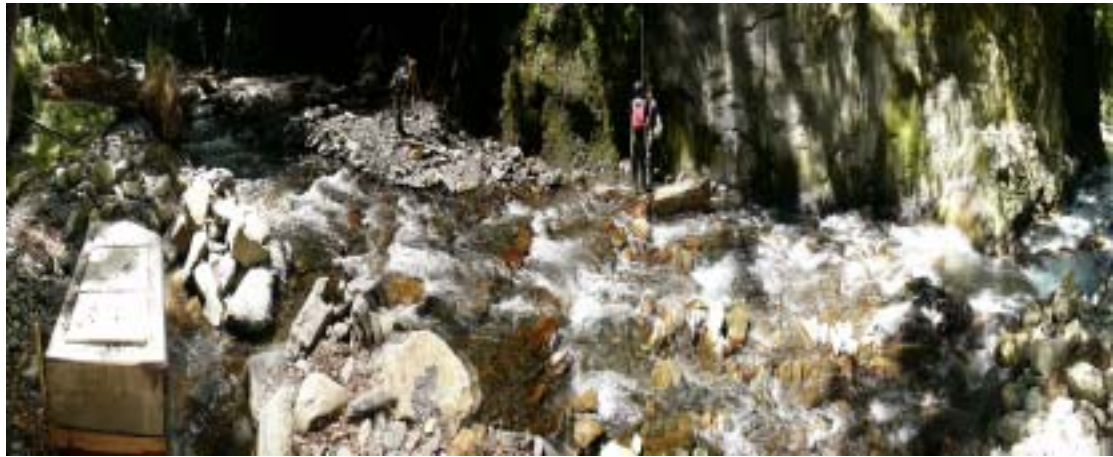
照片 B 三號壩廣角照片
