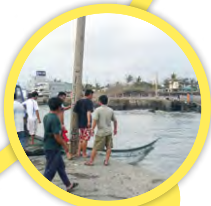
⑧ 完成佈設攔木索及攔木網。
