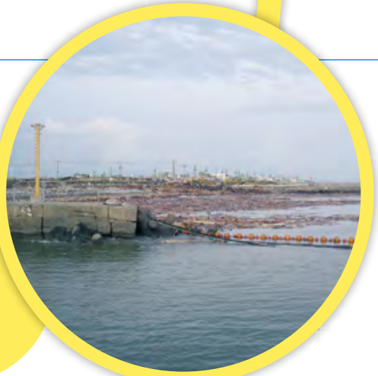
⑨ 遭攔木索、攔木網阻擋在港區外之漂流木實景。
