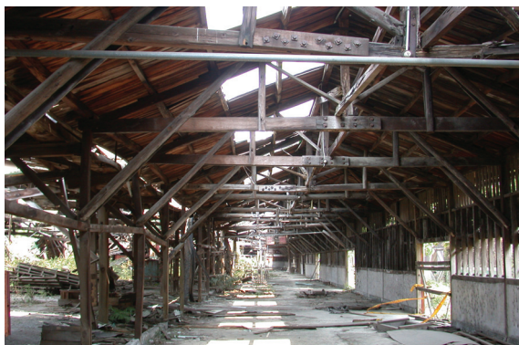
圖2 車埕製材工廠木結構建築
