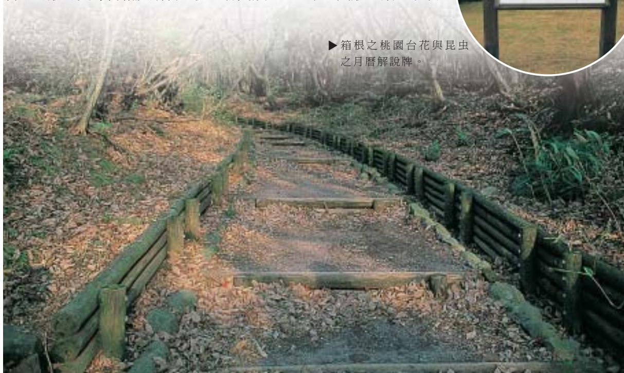
▲ 姥子自然探勝步道護坡、排水溝均採用生態工法。
