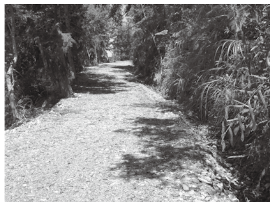
太麻里依麻林道之生態工法路面維護：應用地工材料蜂巢格網加級配夯實作為路基整治材料，其優點在於耐壓、抗沖蝕、透水性高，與周遭景物契合，且有利於草類著生(黃瓊彰攝)
