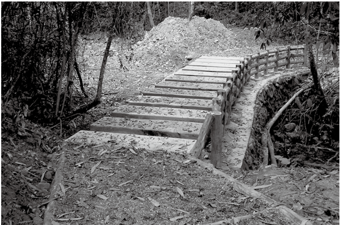
蓮華池生態步道之過水路面：本生態步道結合防腐木料、塊石、級配、混凝土構造物所建構完成。其中之天然排水溝於豪雨時水量相當大，為兼顧安全和排水需求，設計為涵管加過水路面，並具有生態保育及親水的功能(黃瓊彬 攝)
