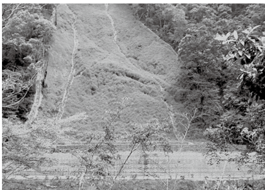
福山林道4.5k崩塌地生態工法復舊：2005年龍王颱風為台灣東北部帶來豪雨，引發林道上邊坡的崩塌地。經調查分析後，規劃以RC擋土牆加箱籠穩定基腳、截水溝系統導引地表逕流、掛網植生保護坡面，堪稱典型之生態工法(黃瓊彬攝)
