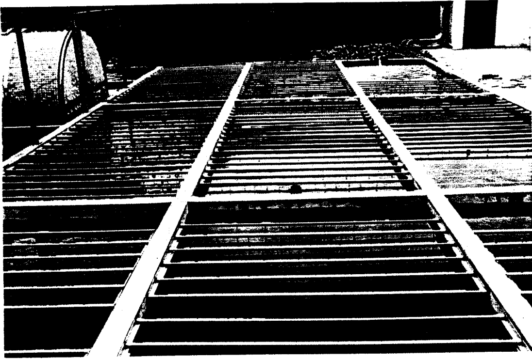
照片2-1 毛刷循環過濾系統
