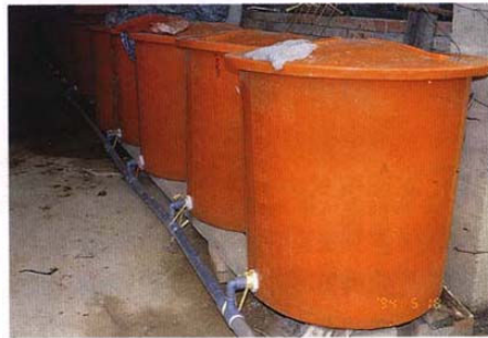
④ 當 300 公升大桶集滿時，應加蓋以免滋生蚊蠅，桶子下方預留廢水排出孔。
