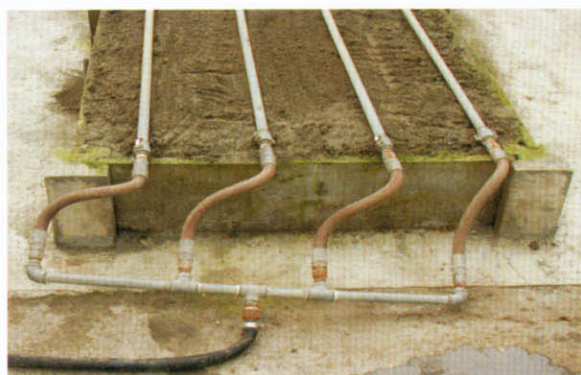
蒸氣管路安裝
