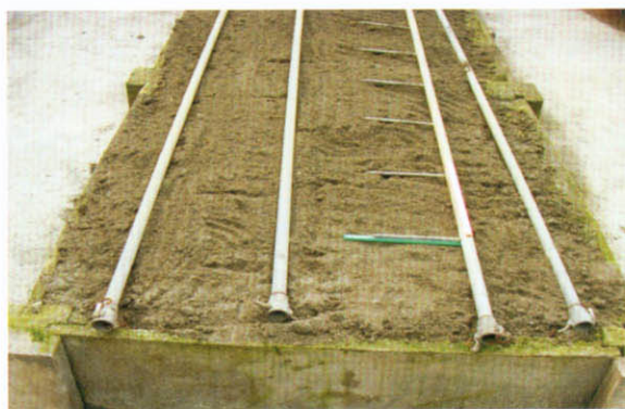
蒸氣管路安裝
