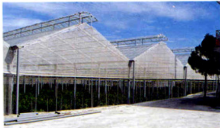
屋頂以透明塑膠布覆蓋的太子樓溫室外觀，顯得頗為清爽通風
