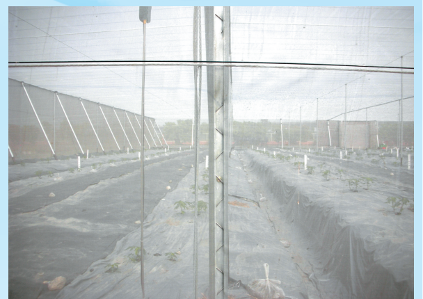
圖4. 以固定壓條及塑鋼繩固定塑膠網
