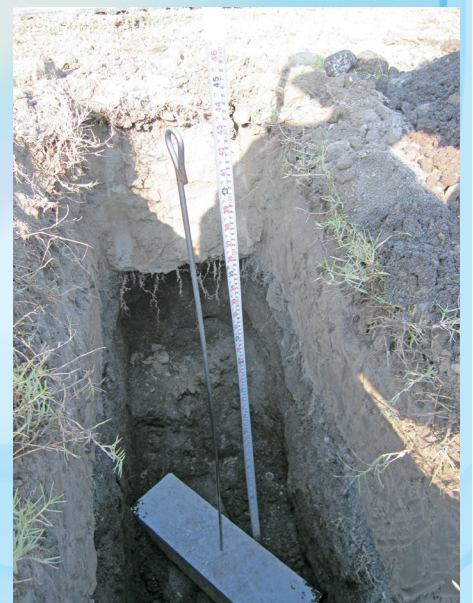
圖3. 結構加強型木瓜網室所使用之地錨
