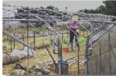
設施蔬菜栽培前塑膠布網室搭建情形
