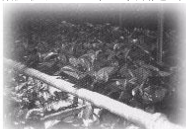
溫泉水循環於溫室鐵管中，利用蒸散熱使溫室保持 15~25°C
