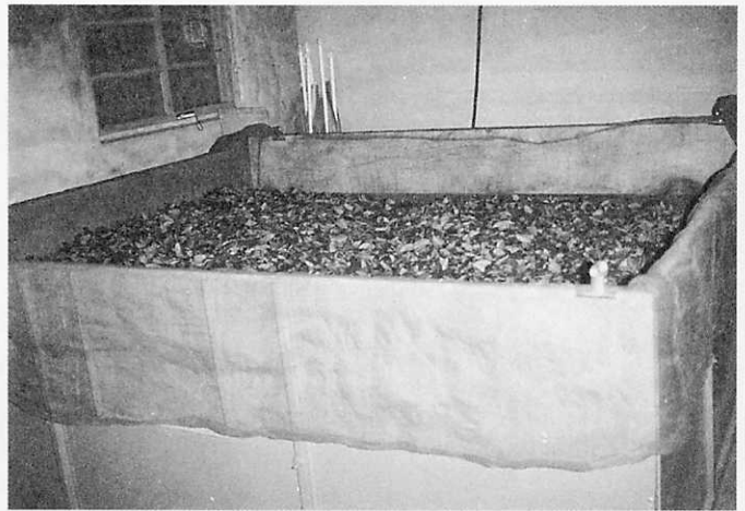
圖二、以往利用萎凋槽去除濕茶菁水份之情形
