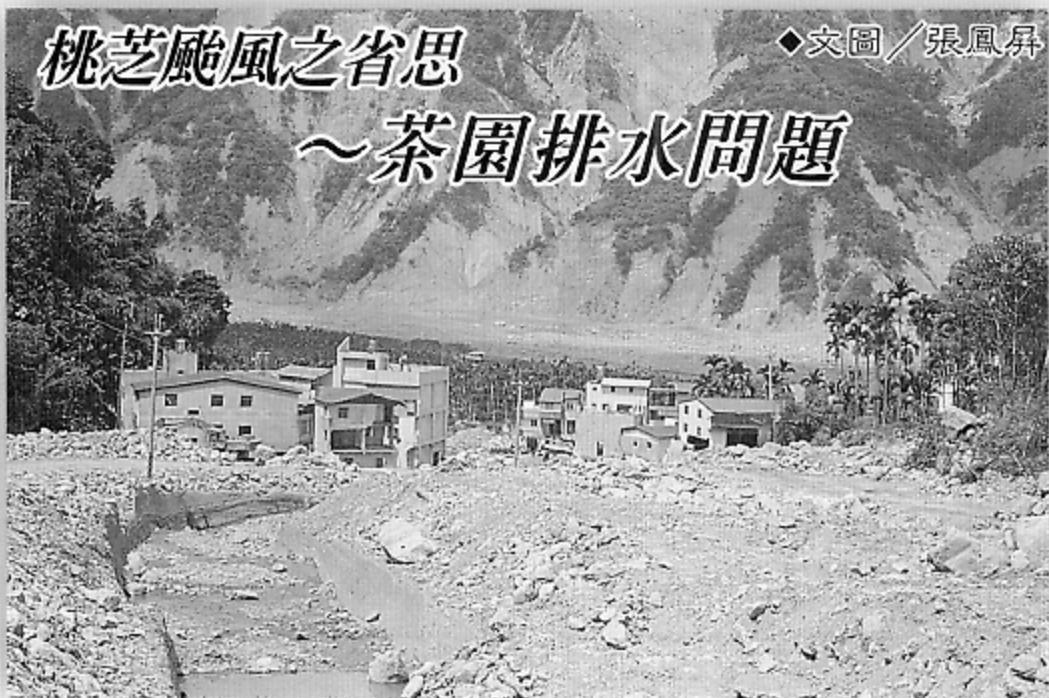
▲土石流危害南投水里上安村情形
