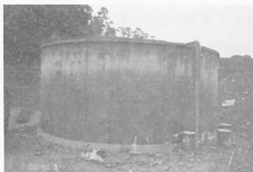
▲圖4. 鋼筋混凝土蓄水池
