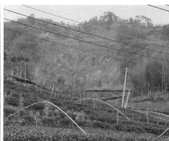
●風雨造成土壤滑動灌溉管線毀損情形
