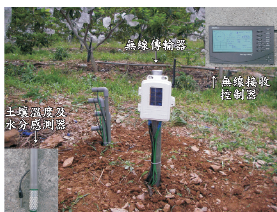
圖3.土壤水分感測系統田間安裝情形
